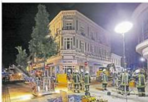
In der Nacht gab das erste Obergeschoss eines dreistöckigen Wohn- und Geschäftshauses in der Grabenstraße Ecke Englerthstraße nach. FOTO MICHAEL GROBISCH
