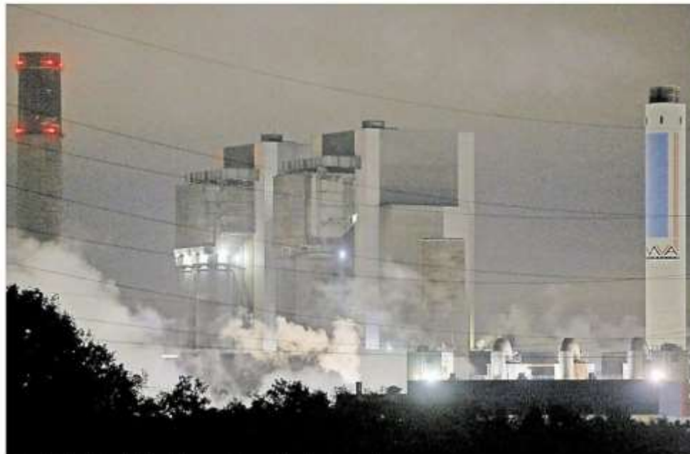
In einem Block des Kraftwerks Weisweiler kam es am Donnerstagabend zu einem Brand.
