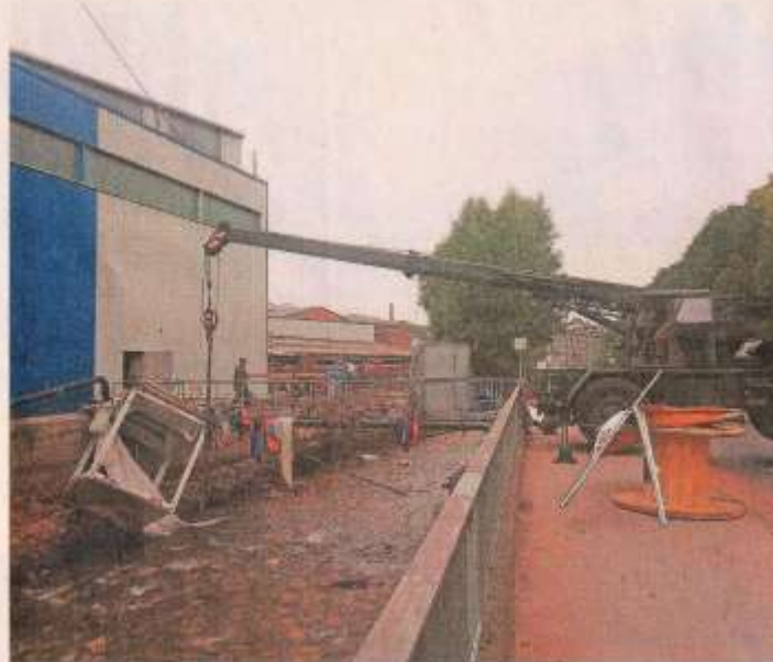
Die Räumung des Vichtbachs war eine zentrale Aufgabe der Wehr.
