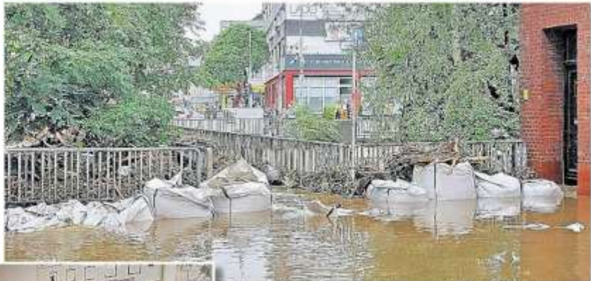
Am Morgen des 15. Juli offenbarte sich allmählich das Ausmaß der Schäden. Der Versuch der Feuerwehr, die Brücken vor den Wassermassen zu schützen, war in der Nacht zuvor gescheitert. Axel Johnen (links, links), Leiter der Eschweiler Feuerwehr und der Hauptwache, hier mit Rechtsdezernent Dieter Kemp, blickt auf extreme Wochen und Erfahrungen zurück.
