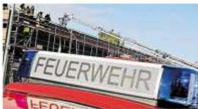
Im Notfall muss sie zur Stelle sein. Die Eschweiler Feuerwehr ist als „letztliche Instanz“ besonders zu schützen und hat besondere Vorsichtsmaßnahmen ergriffen.
