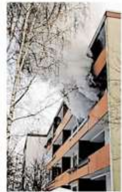
Dichter Rauch dringt aus einer Wohnung an der Gutenbergstraße. Ein Rauchmelder schlägt Alarm, ehe es zur Katastrophe kommt.
