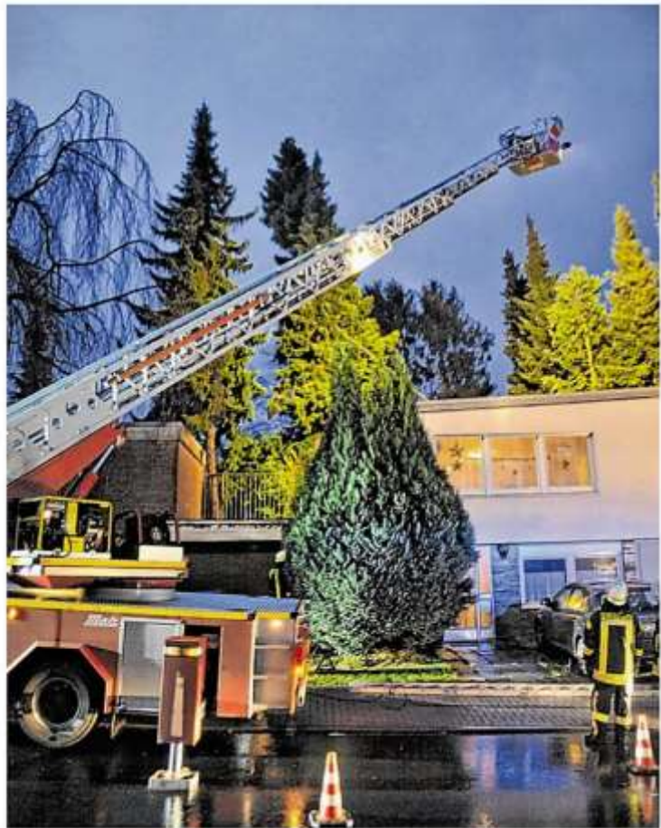
Risikofällung mit Drehleiter-Hilfe am Mittwochabend an der Dreieckstraße. Hier drohte eine ausgewachsene Tanne auf ein Wohnhaus zu stürzen. Foto: Rudolf Müller
