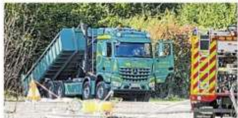
Mit Großraummulden wurden die 367 Kanister von einem Herzogenrather Entsorgungsunternehmen abtransportiert.
